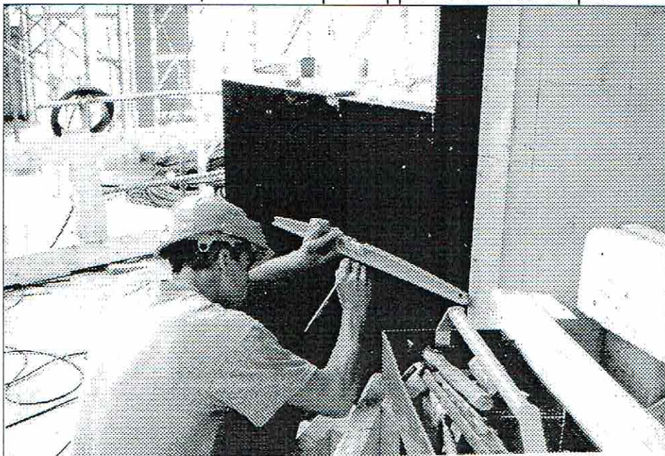
mise en place du fut tracé des marches, remontée par rapports a la vue en plan
